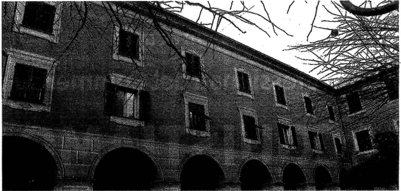
Il Palazzo della cultura di piazza Ravenna a Lavagna: ospita la biblioteca comunale, la sala Albino e quella delle ardesie. È tra le sedi dei corsi di Unitre
